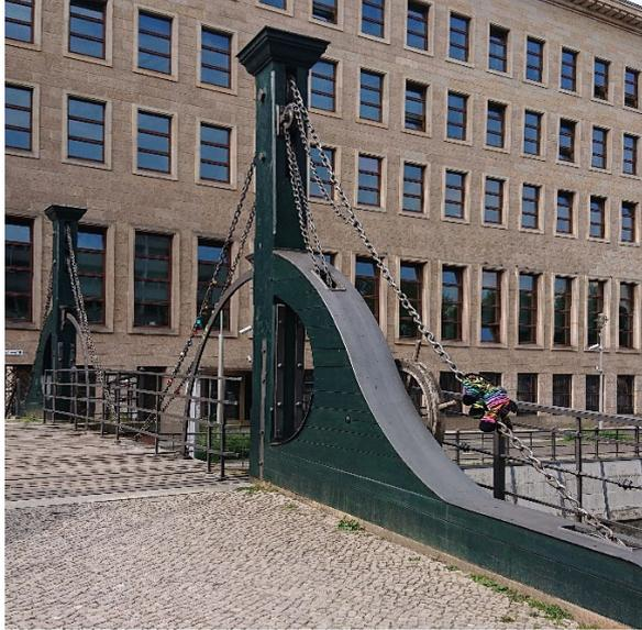
Die heißt „Jungfernbrücke“ und ist eine Klappbrücke, sogar die Älteste in Berlin.
